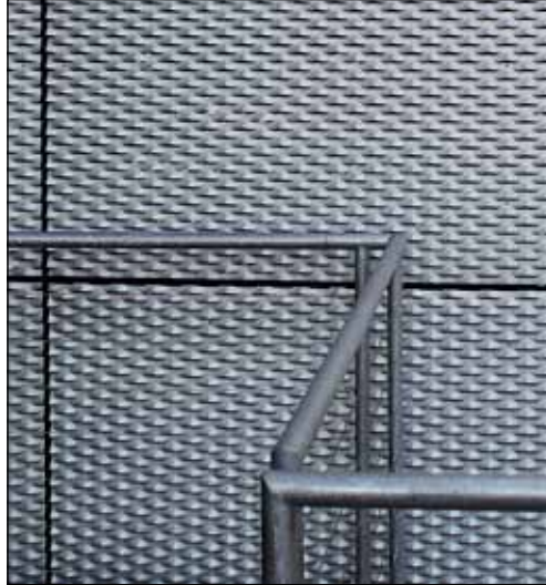
2 Nachhaltig: Verzinkte Fassade von ingenhoven architects
