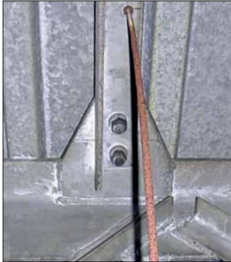
3 Top: Verzinkte Bauteile nach 35 Jahren
