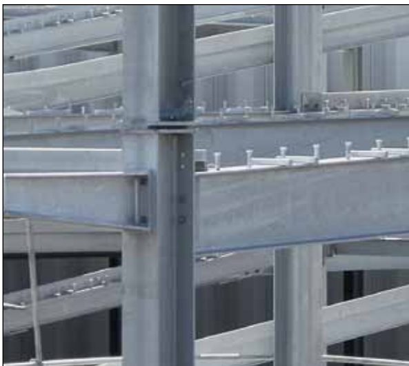
4 Feuerverzinktes Stahltragwerk eines Parkhauses
